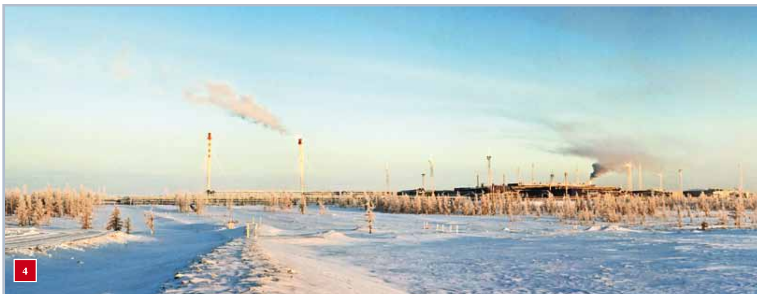
4. УСТАНОВКА КОМПЛЕКСНОЙ ПОДГОТОВКИ ГАЗА №2В ЗАПОЛЯРНОГО МЕСТОРОЖДЕНИЯ (ФОТО ОАО "ГАЗПРОМ")
